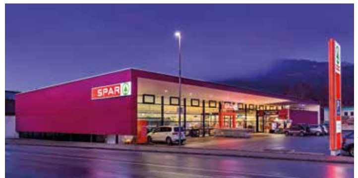
Der Spar-Supermarkt Bärnbach wurde komplett modernisiert
